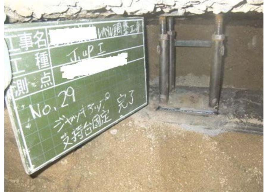
支持台およびジャッキ設置完了。室内でレベル測量を行いながらジャッキアップ。
