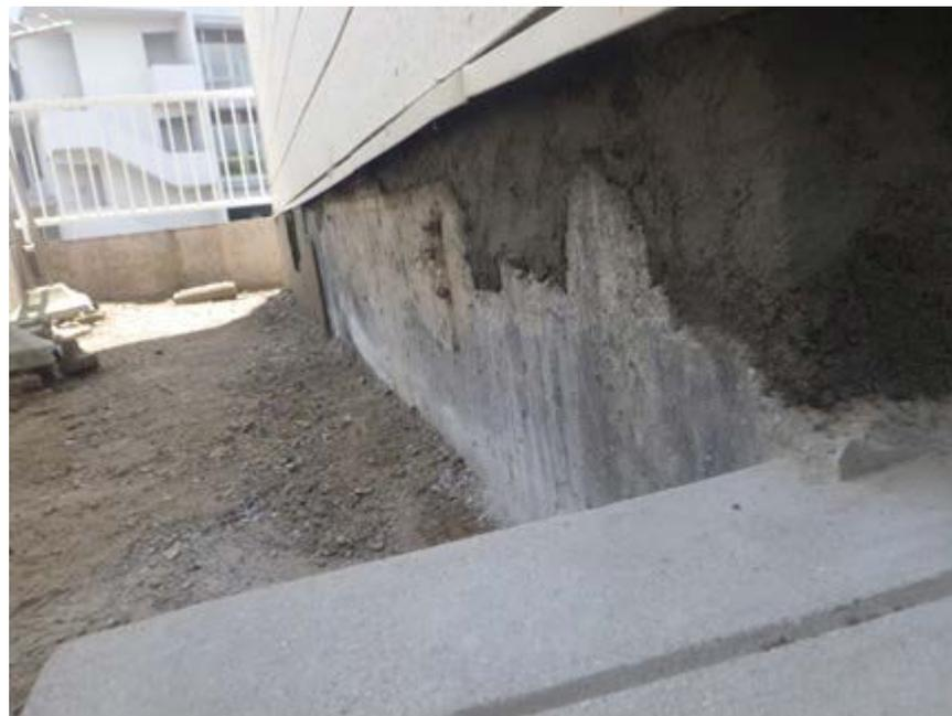
ジャッキを撤去し、基礎と土台の隙間にモルタル充填。
