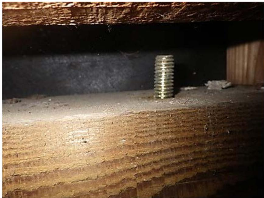
ナットを外し、アンカーボルトを開放。
