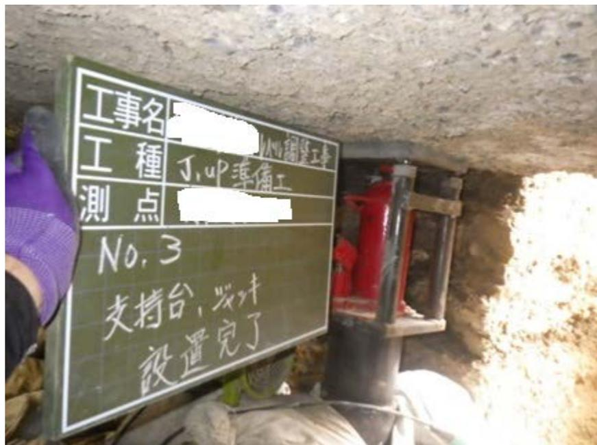
圧入完了後、支持台及びジャッキを設置。室内でレベル測量を行いながらジャッキアップ。
