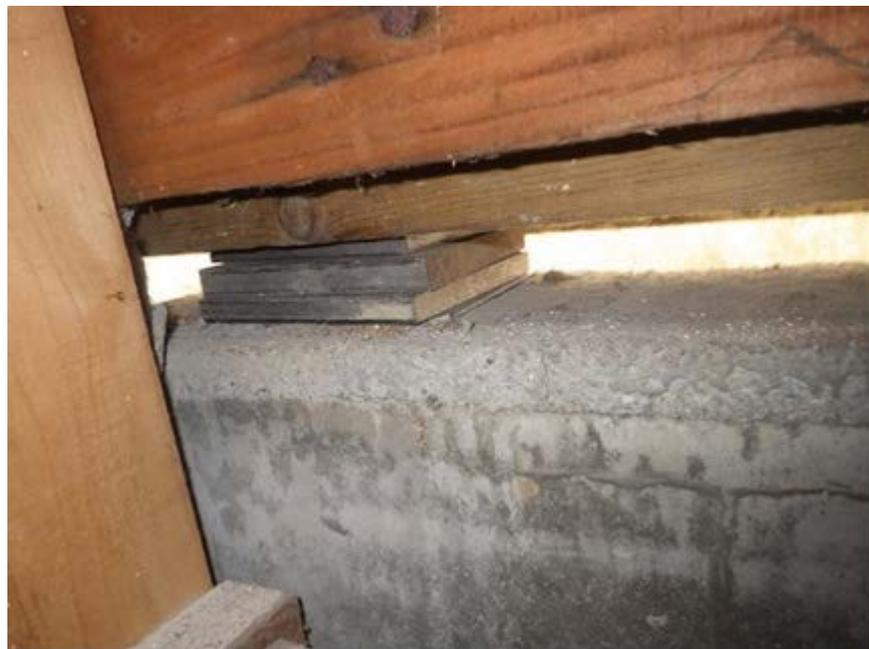
測量しながらジャッキアップし建物レベルを調整。基礎と土台の隙間に鋼板プレートを設置。
